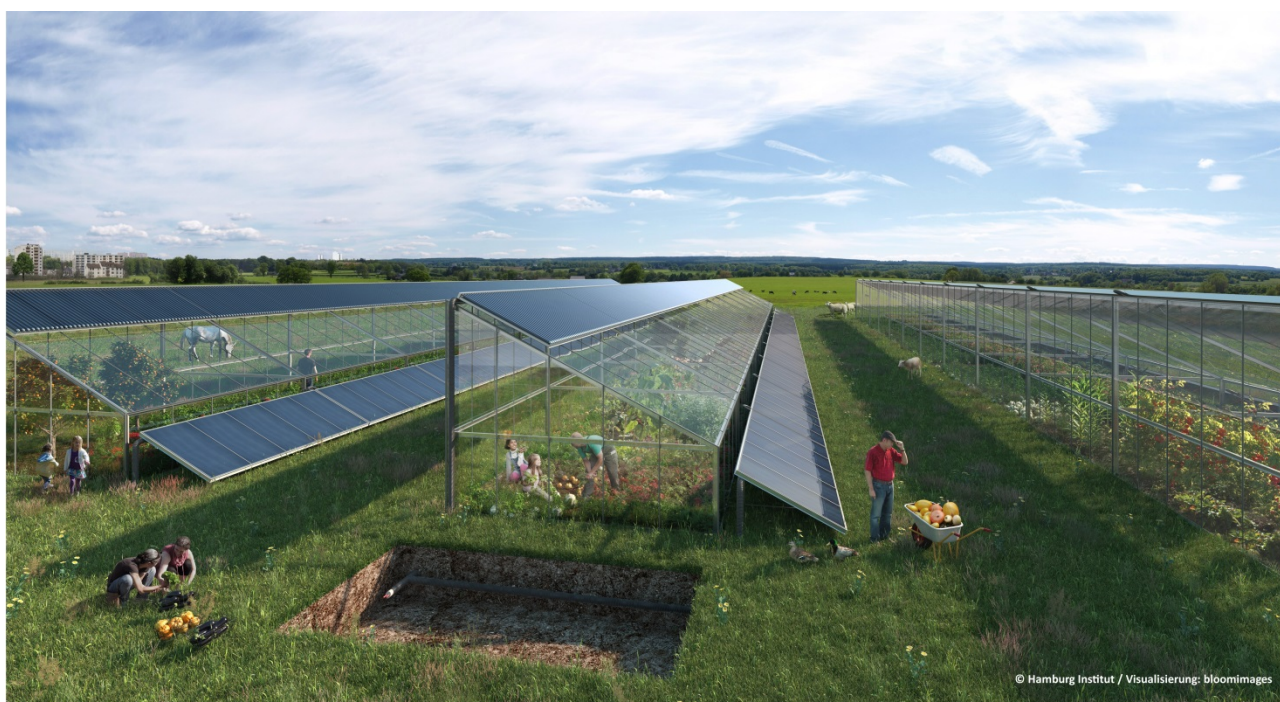
Possibile 'doppia utilizzazione' di un terreno agricolo con impianto solare e coltivazioni
