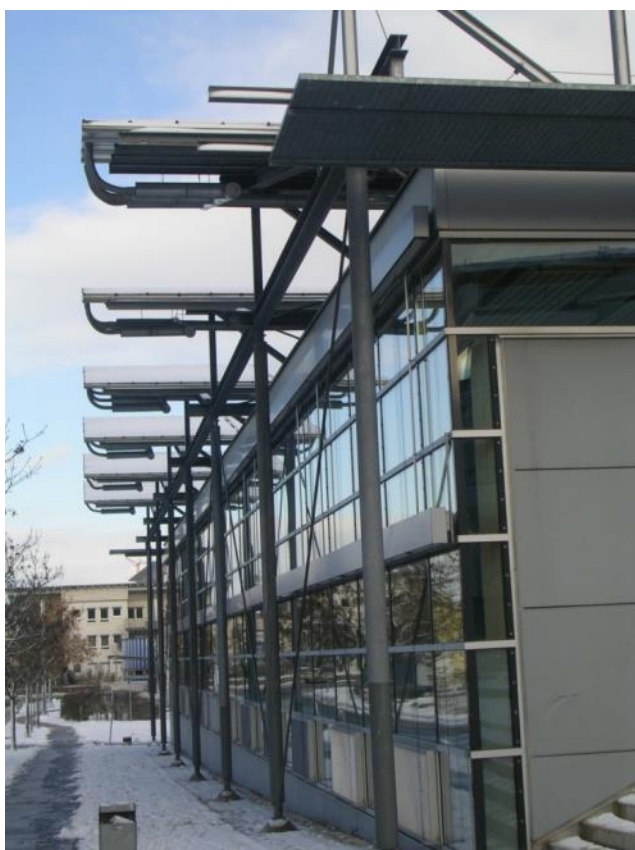
Impianto di teleriscaldamento solare posizionato sul tetto di una palestra
