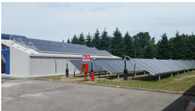
Una parte dell'impianto di teleriscaldamento solare di Varese
