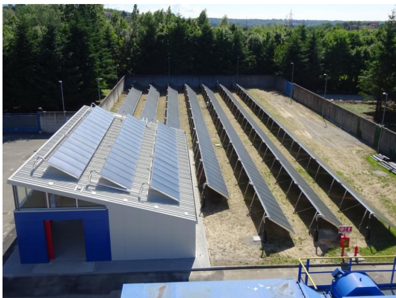
Vista complessiva dell'impianto di teleriscaldamento solare di Varese
