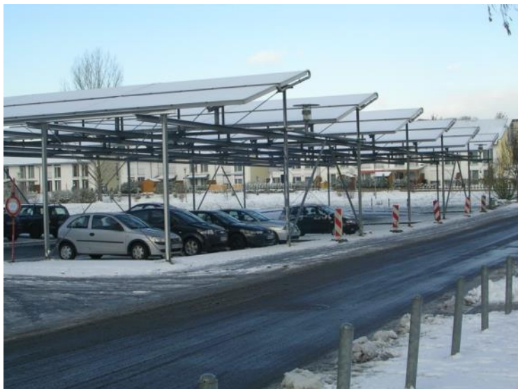
Impianto di teleriscaldamento solare posizionato sulla pensilina di un parcheggio
