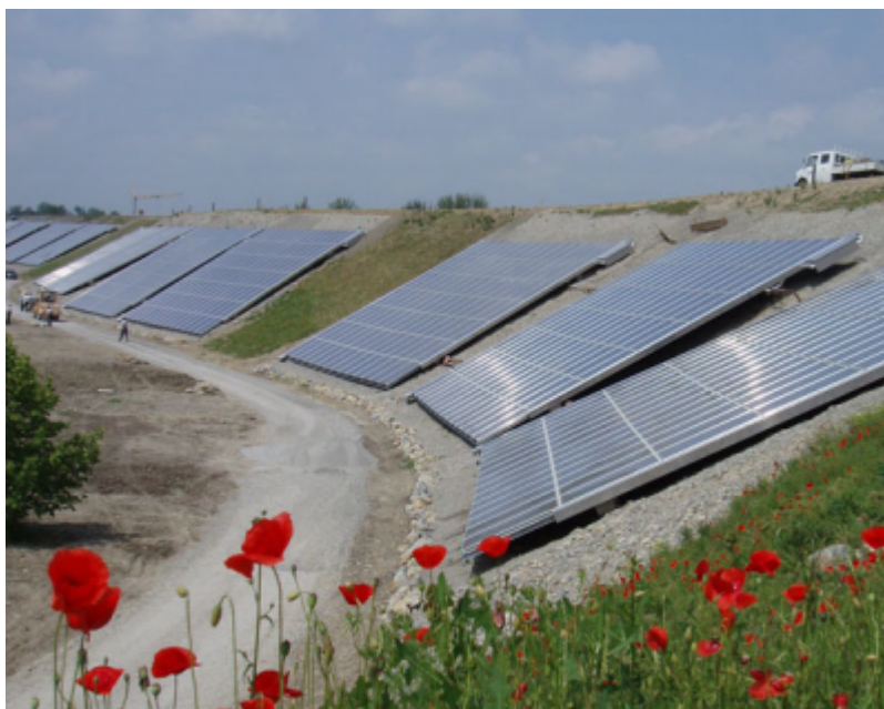
Impianto di teleriscaldamento solare posizionato su una barriera antirumore
